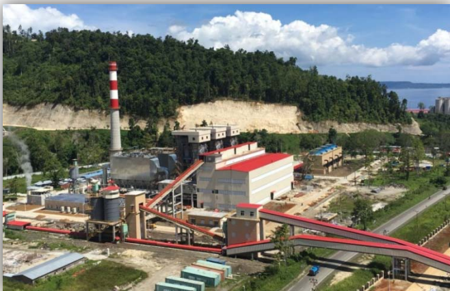
已并网发电的印尼西巴自备电站项目
