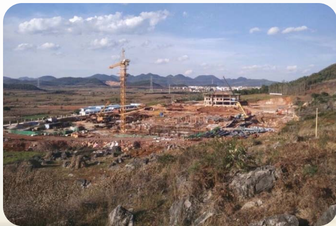
建设中的砚山炉排炉垃圾发电项目
