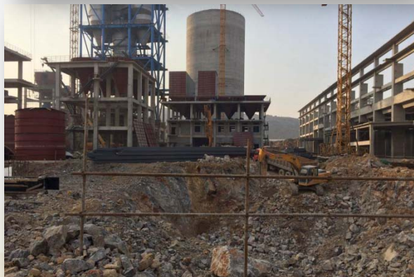
建设中的芜湖、淮北固废处置项目
