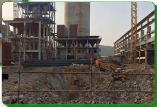
正在建設中的蕪湖、淮北固廢處理項目
