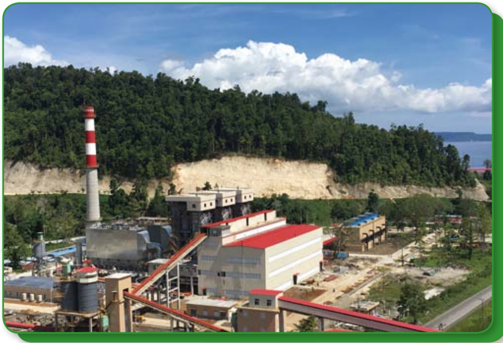
本公司在印尼西巴布亞建設的自備電站項目
