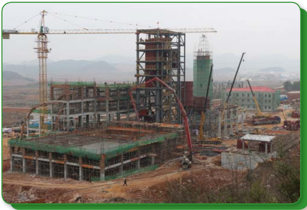
正在建設中的硯山爐排爐垃圾發電項目
