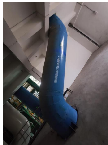
一次风管道（一次风机→空气预热器）
